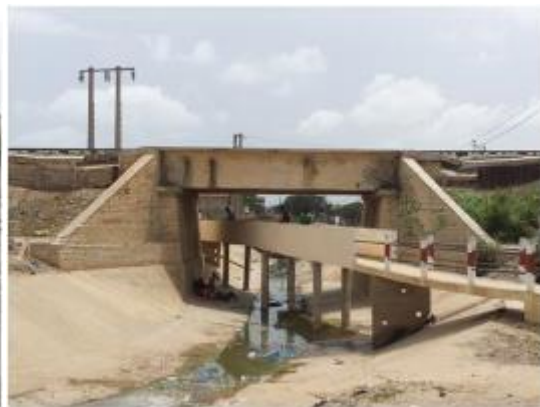
Photo 7 : Ouvrage hydraulique sur le tracé à Rufisque
