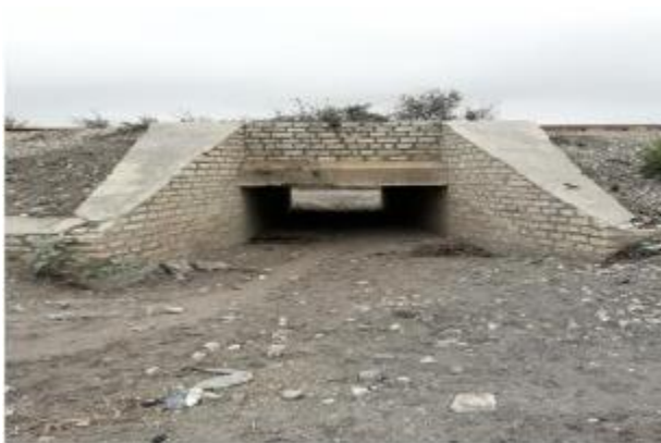
Photo 6 : Dalot enjambant le tracé à Bargny
