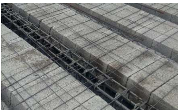
Exemple de hangar avec une dalle hourdis
