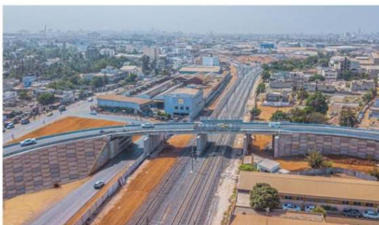
Figure 41 : Exemple de PRO au niveau de Dakar (tronçon Dakar-Diamniadio)
