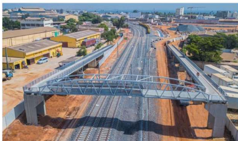
Figure 42 : Exemple de passerelle au niveau de Dakar (tronçon Dakar-Diamniadio)
