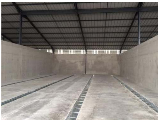
Exemple de hangar avec une dalle pleine
